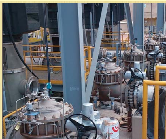
Válvulas de Control de Bomba en Acero Inoxidable, para sistemas de lixiviación
