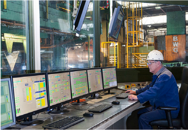
Referencia: Sala de control V7
